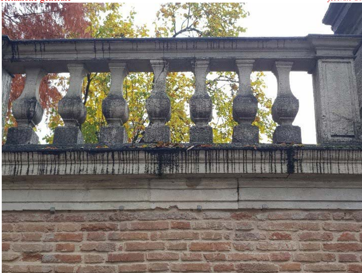
Figura 18 Colature e annerimento delle superfici per deposito superficiale e attacco biologico.
