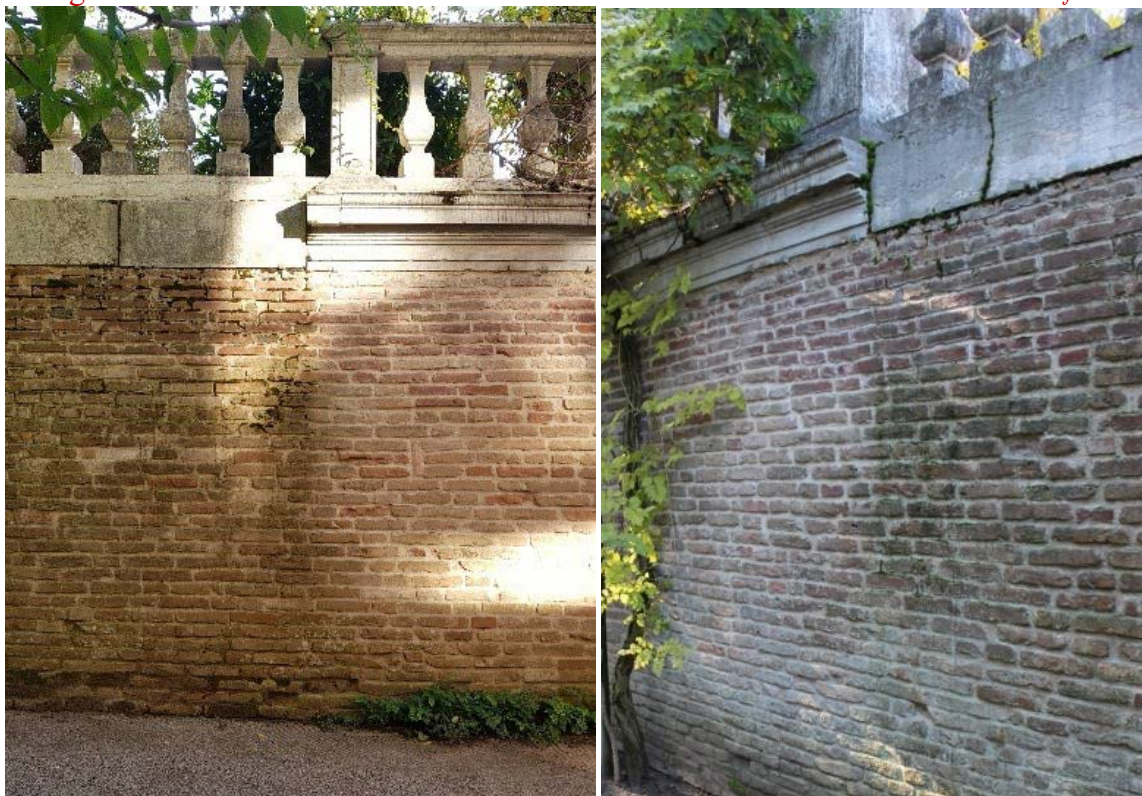
Figura 5413 Caso 2: il muro presenta una netta cesura dovuta alla presenza dell'attacco biologico nella zona non protetta dall'acqua.
