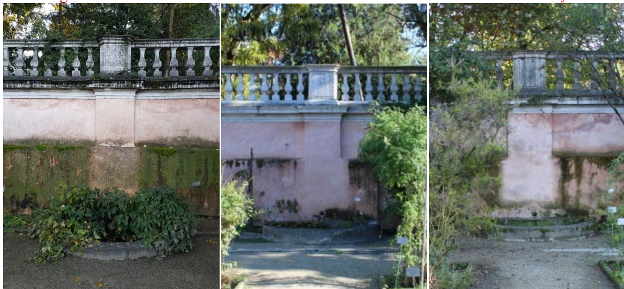
Figura 56 Caso 3. Nelle immagini si nota la diversa morfologia della contaminazione biologica in relazione alla geometria del manufatto; in questo caso il pilastro è protetto dall'aggetto della balastra.
