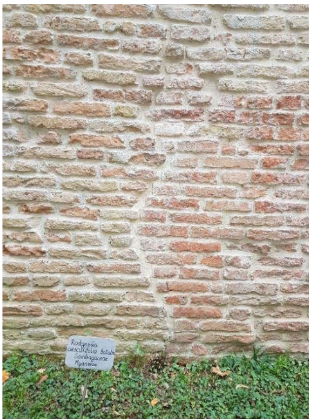
Figura 8 Nell'immagine si nota l'andamento rettilineo dei segmenti di balastra rispetto alla circolarità del muro in mattoni.
