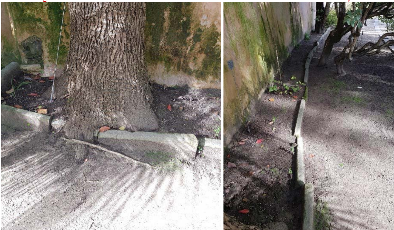
Figura 70 Il caso della Metasequoia: l'accrescimento dell'apparato radicale ha fratturato, inglobato e dislocato il tratto di cordolo adiacente. Gli affetti si ripercuotono anche a distanza in seguito alla pressione esercitata dalle radici sotto il livello del terreno, come si vede nei numerosi cordoli dislocati.
