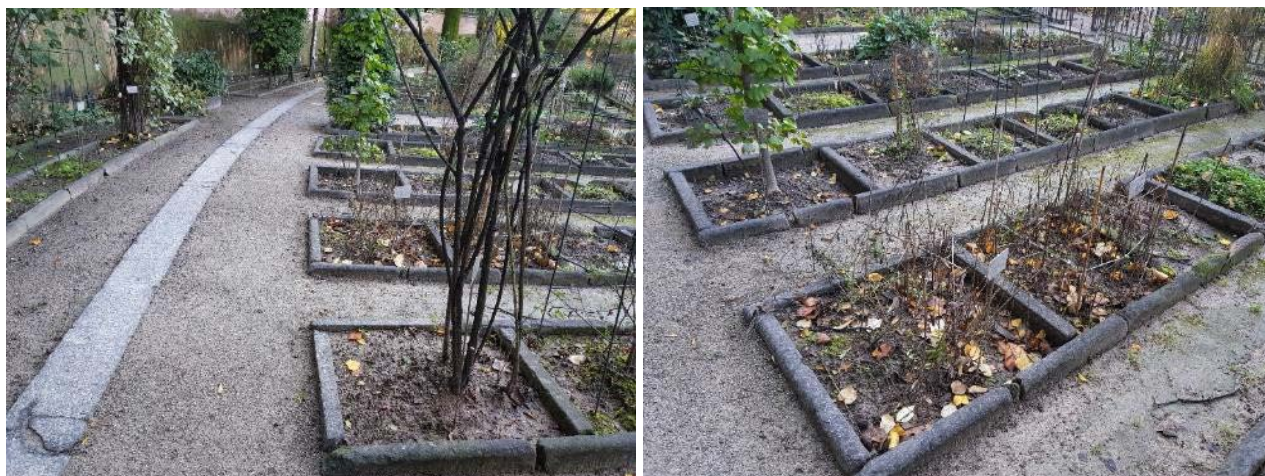
Figura 39 Cordoli interessati da dissesti nei piani di posa, fratturazioni e mancanze.
