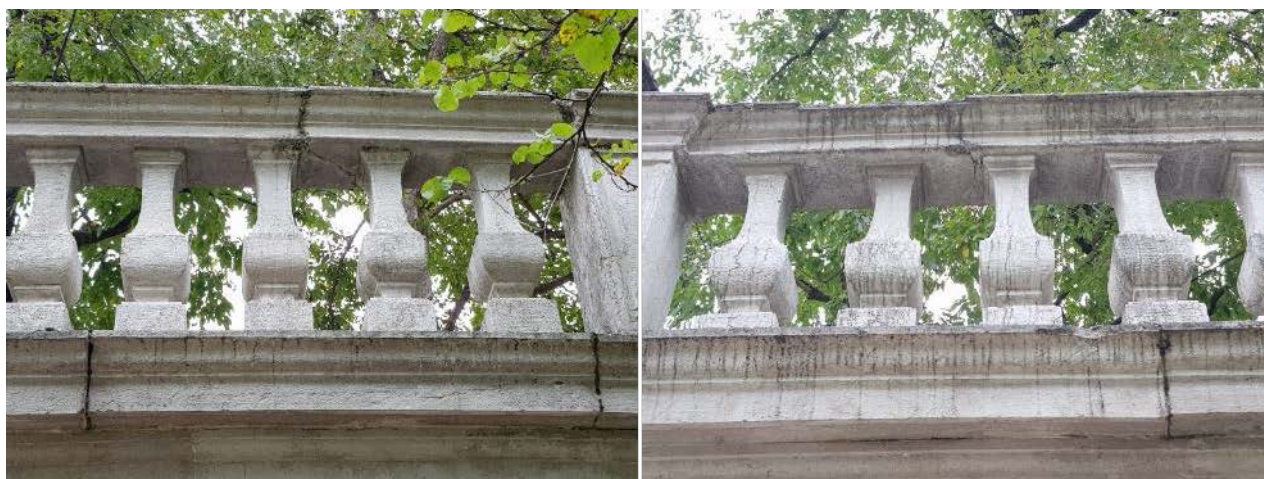
Figura 21 La cimasa della balastra presenta fratturazioni di non recente formazione, evidenziate dal deposito superficiale.
