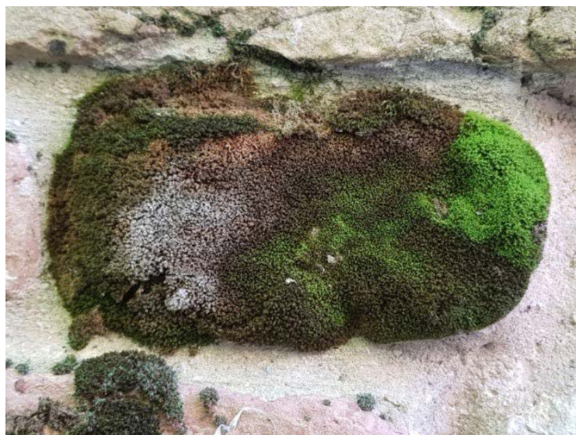
Figura 28 Un caso isolato di laterizio ricoperto da un tappeto di briofite.
