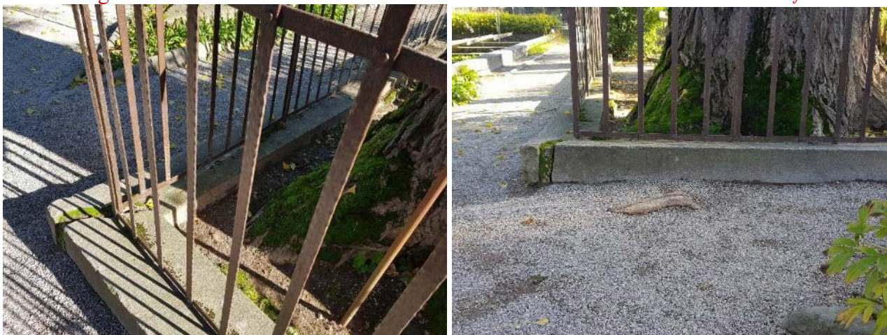
Figura 72 Si nota la stuccatura realizzata per risarcire la frattura all'estremità del cordolo. Nell'immagine a destra si individua la posa del tratto terminale della cancellata, non in asse con la linea di mezzzeria del cordolo.
