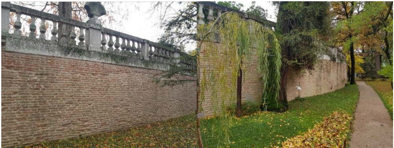
Figura 29 Lato esterno del settore sud – est e sud – ovest. Il paramento in laterizi è per ampie porzioni quasi del tutto libero dall'attacco biologico.
