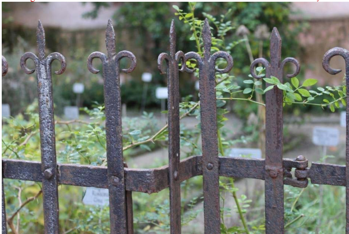
Figura 20 Le cancellate presentano aste in ferro con motivo terminale a lancia. Si riscontrano numerose varianti in merito alla foggia e allo spessore delle lance, indicative di autori differenti e interventi sostitutivi.
