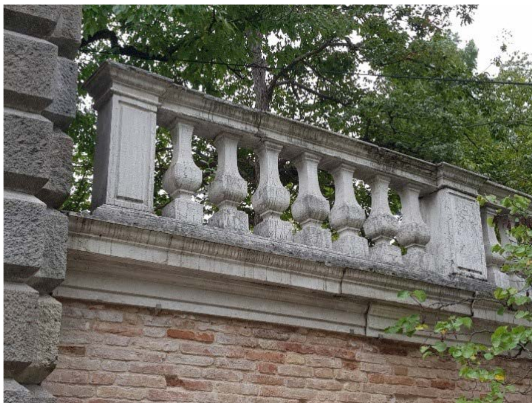
Figura 14 Nelle immagini sono visibili i disallineamenti nei blocchi, l'alternanza di blocchi di lunghezze differenti e le zanche di sostegno.
