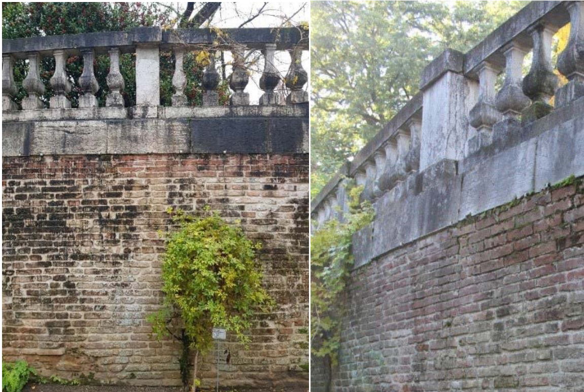
Figura 12 Caso 1: il pilastro non presenta attacco biologico perché protetto dall'aggetto della cimasa; nell'immagine a sinistra la situazione si estende anche al sottostante paramento in laterizi.
