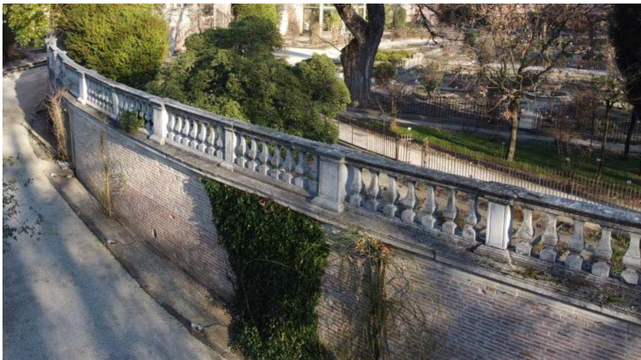
Figura 8 Nell'immagine si nota l'andamento rettilineo dei segmenti di balastra rispetto alla circolarità del muro in mattoni.
