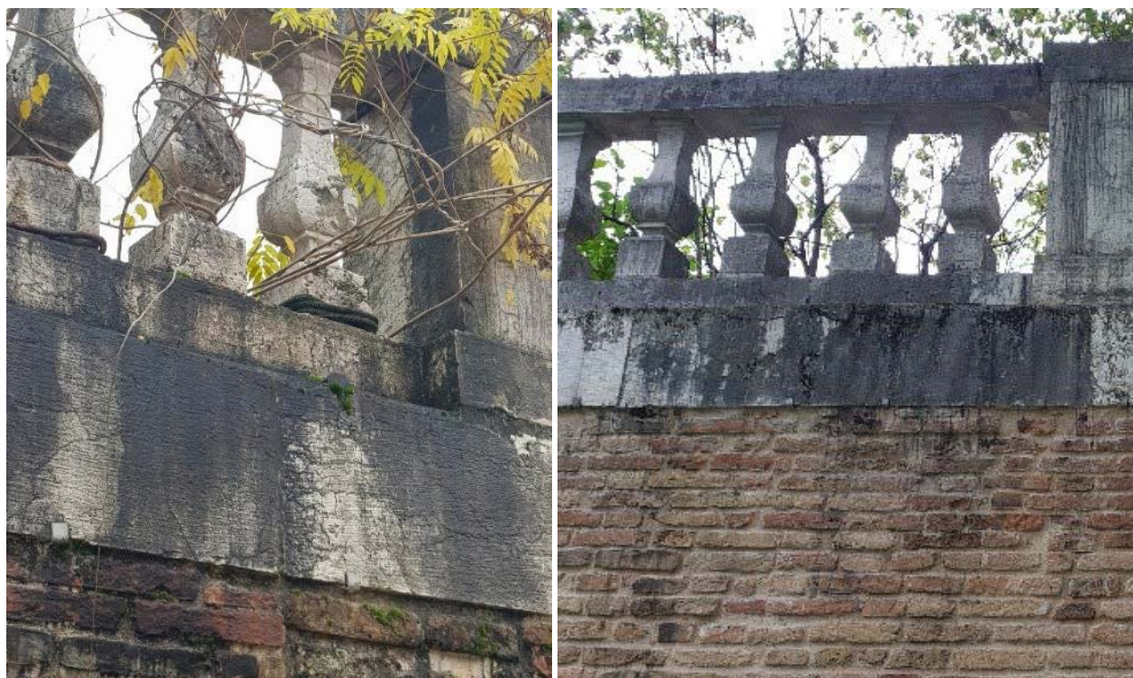
Figura 19 Annerimento delle superfici di grave entità.
