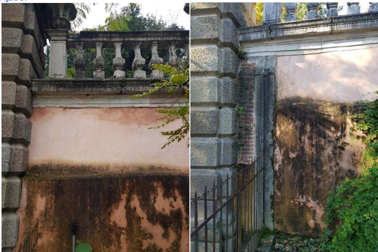
Figura 11 Nelle immagini è chiaramente visibile come la geometria del manufatto balastra/muro condizioni la distribuzione dell'attacco biologico secondo quanto riportato nel testo. Nell'immagine a destra, la fenomenologia si ripete in corrispondenza dei piccoli pilastri addossati alla muratura in adiacenza alla Porta ovest: bagnati dall'acqua ruscillante dalla balastra, sono oggetto di contaminazione biologica.
