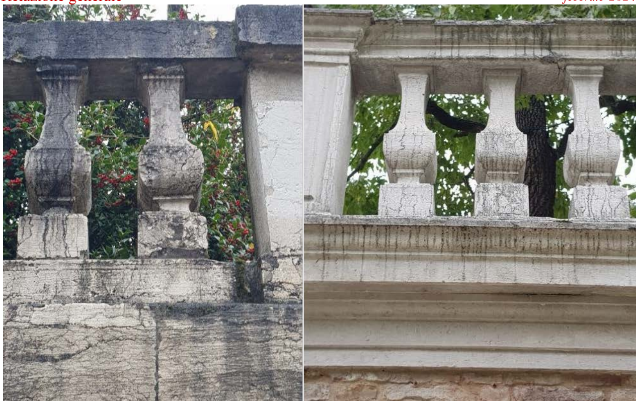
Figura 16 Nelle immagini si distinguono i piani di sedimentazione nel materiale lito, che provocano un degrado differenziale.
