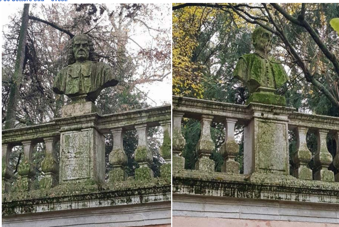
Figura37 I busti a coronamento della balastra sono interessati da attacco biologico di grave entità.
