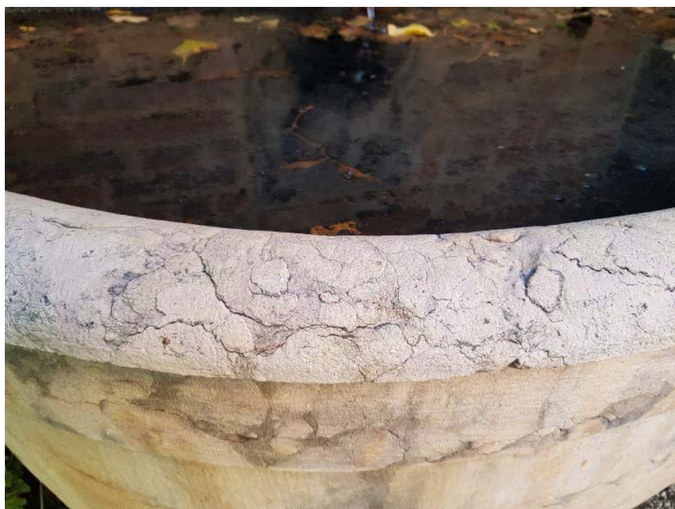
Figura 22 Vasca semicircolare addossata al muro esterno, settore nord – ovest, fenomeni di scagliatura di lieve entità.
