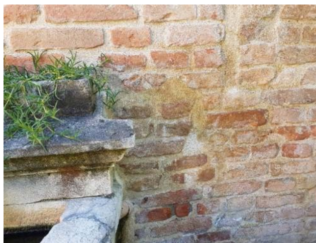
Figura 9 Cedimenti strutturali nella muratura ormai assestati, come possibile appurare dall'assenza di crepe nella malta delle stuccature realizzate nel restauro di quindici anni fa.
