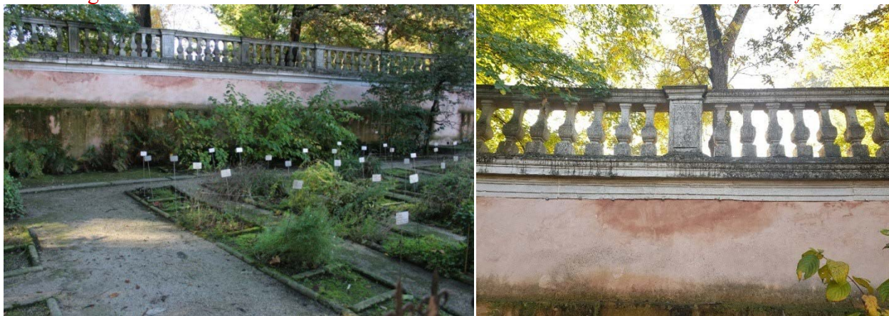
Figura 15 Nelle immagini è evidente la formazione delle gore in corrispondenza di giunti (immagini in alto, evidenziati dalle frecce) e pilastrini.
